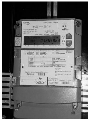
Ілюстрація 11: Цифровий лічильник електроенергії
