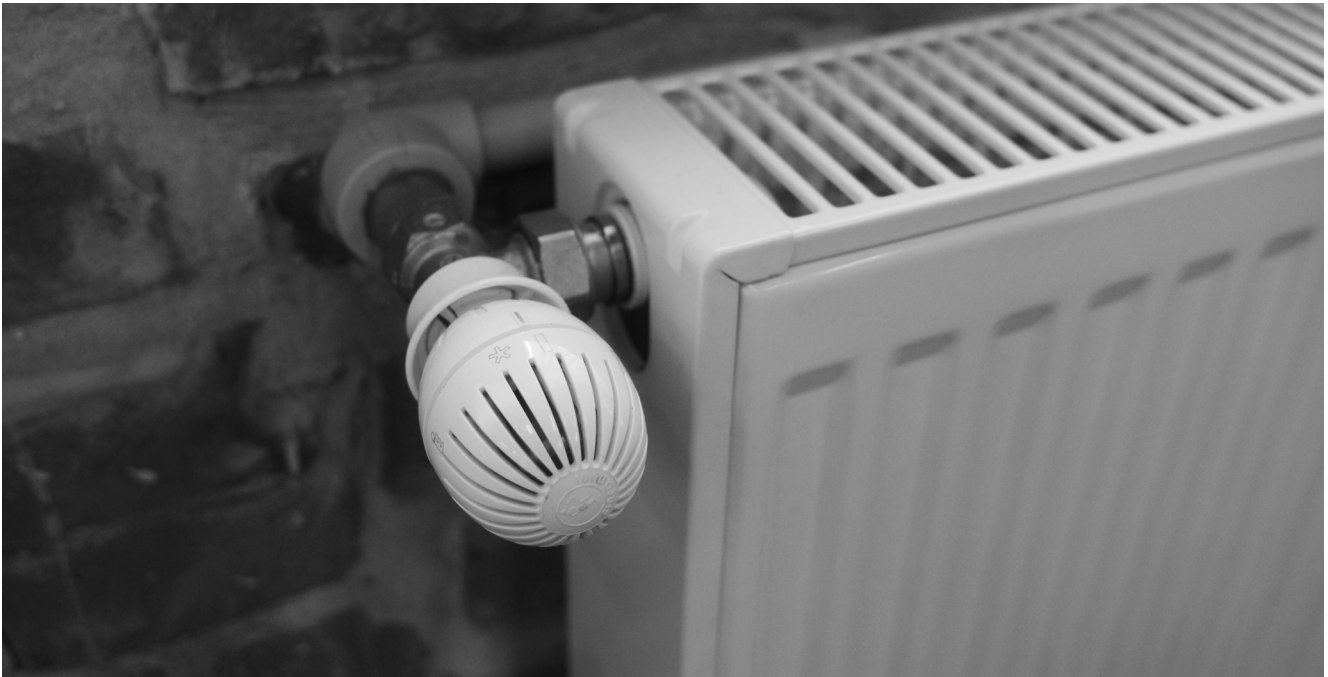
Рисунок 20: Радіатор з термостатом
