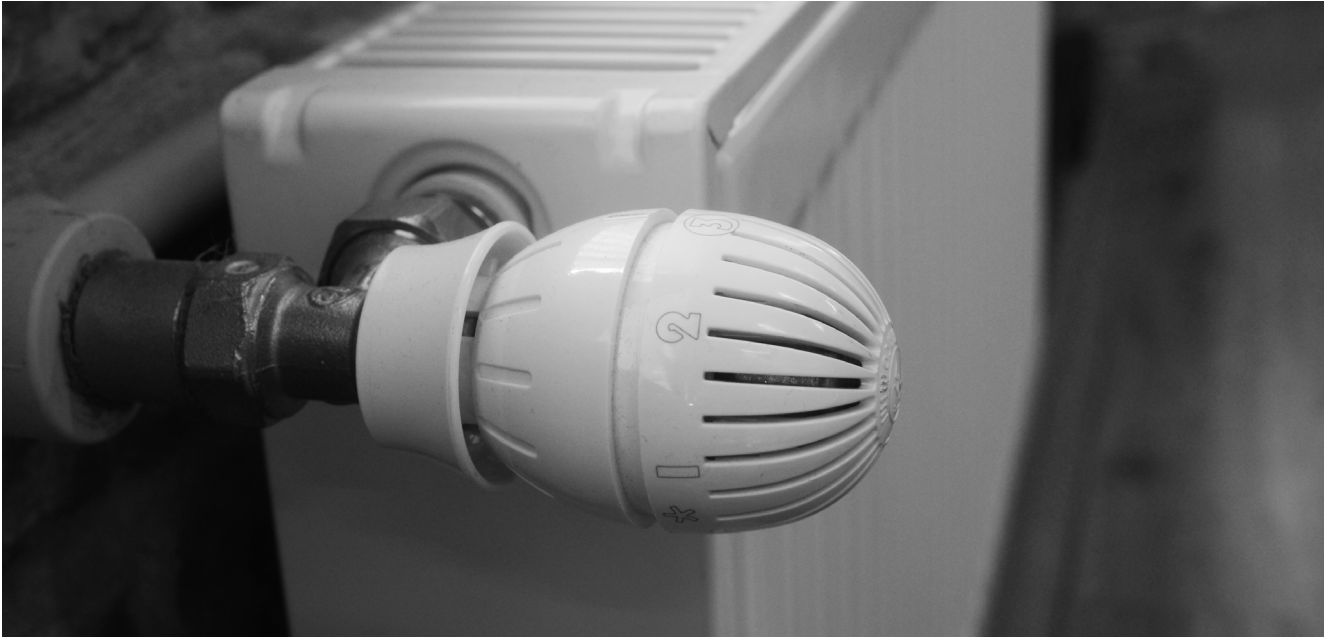
Рисунок 19: Термостат для регулювання кімнатної температури
