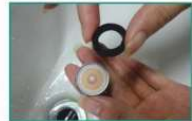
Крок 3: Вставляємо водоратор у металевий корпус та зверху накриваємо прокладкою
