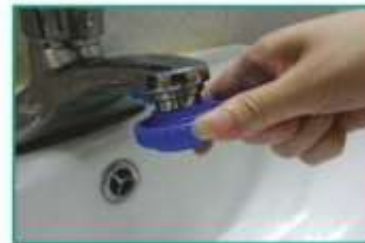
Крок 1: Відкручуємо металевий корпус з стандартним розпилювачем
