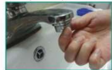
Крок 4: Прикручуємо металевий корпус з водоратором назад на змішувач та економимо воду
