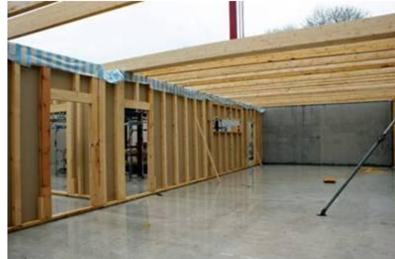
Встановлення конструкції плоского даху
