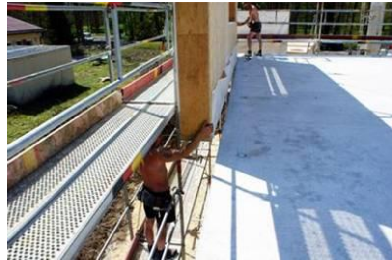
Установка елемента дерев'яної панелі
