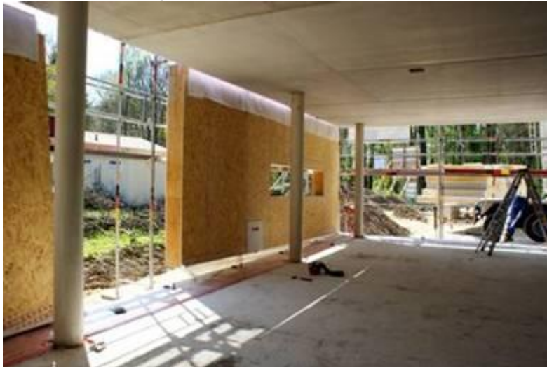
Установка зовнішньої стіни на 1 поверсі
