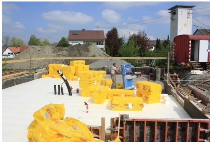
Піщана подушка під ізоляцією
