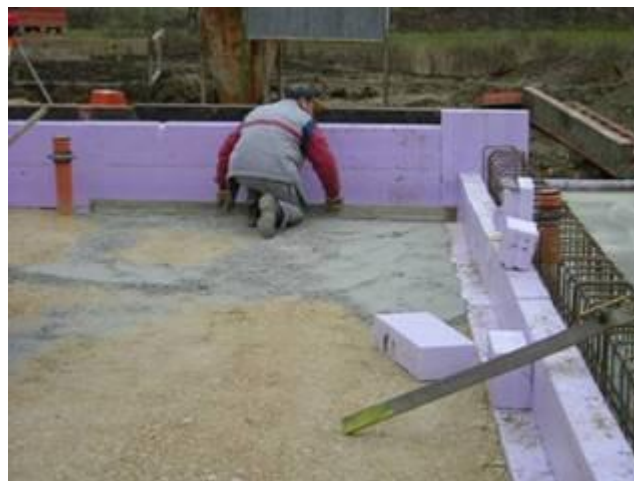
Піщана подушка під ізоляцією
