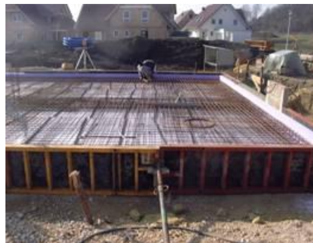
Арматура на ізоляції
