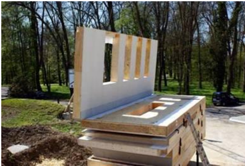
Елемент дерев'яної панелі після доставки
