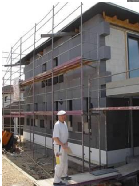
a) Mauerwerk mit Wärmeverbundsystem (über 25 cm dick)
