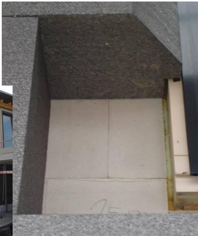
a) Mauerwerk mit Wärmeverbundsystem (über 25 cm dick)
