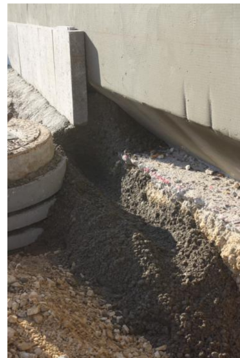
Теплоізоляційний клин захищено бордюром
