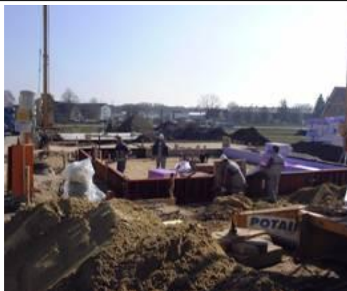
Укладання шару теплоізоляції
