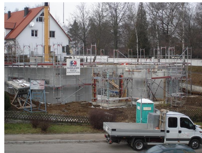
Опоры + опалубка на плиті основи
