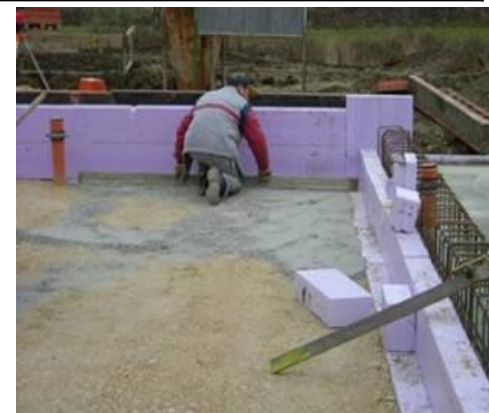
Піскова подушка під теплоізоляцією
