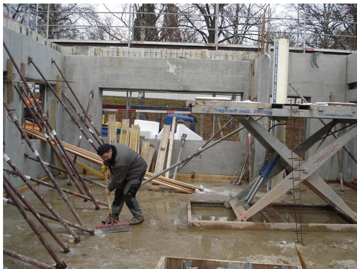
Готові буделементи на плиті основи
