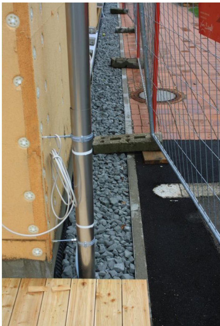
Точка підосви стіни з масиву деревини
