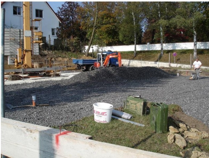
Нанесення склопінного щебеню екскаватором
