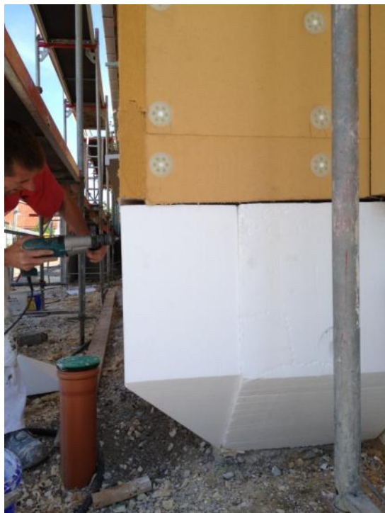
Теплоізоляційний клин з теплоізоляції периметру
