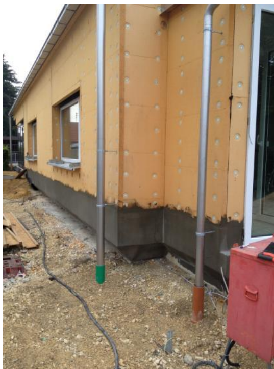
Теплоізоляційний шар покрито герметизаційною чорною мастикою
