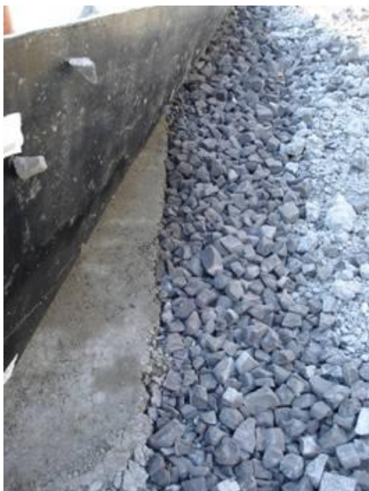
Під плитою фундаменту
