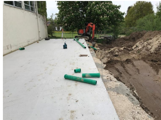
Еластично укладена фундаментна плита
