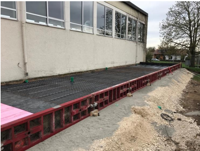
Обшивка фундаментної плити з арматурним укріпленням
