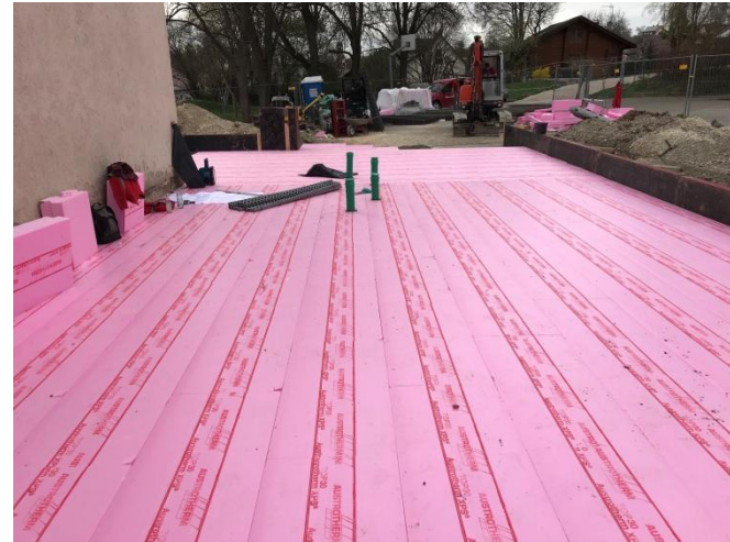
20 см теплоізоляція XPS під фундаментною плитою
