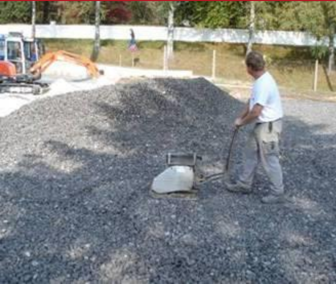
■ Гравій із піноскла під опорною плитою
