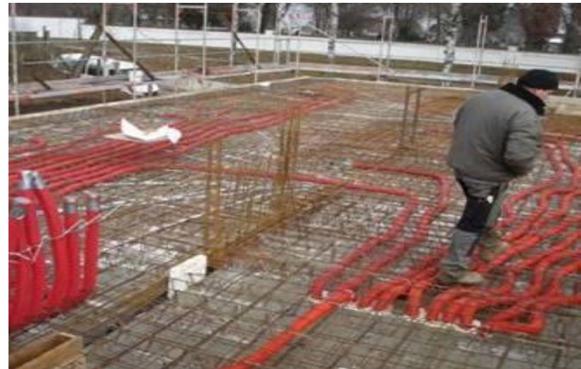
■ Вентиляційна розводка у стелі
