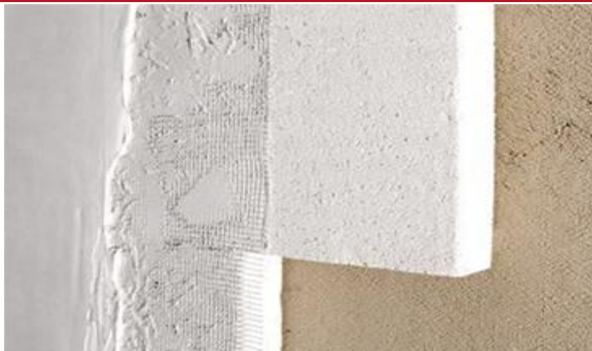
Внутрішня ізоляція стін
