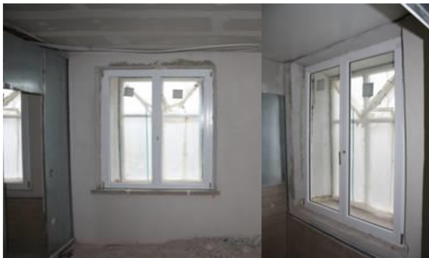
Зовнішня стіна, OG Аутенрід
