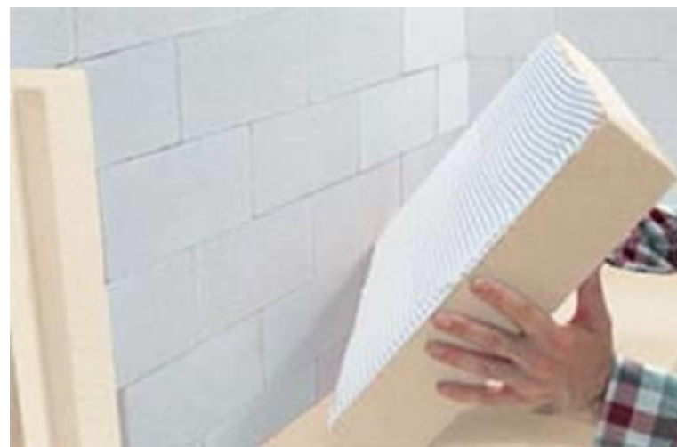
Наклеювання піномінеральної плити
